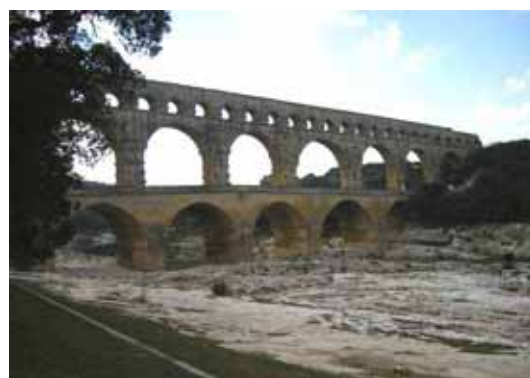
<写真：ガール水道橋>
