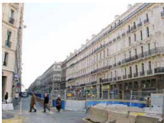
<写真：レパブリック通りの修復工事 (道路部は市電の設置工事)>
