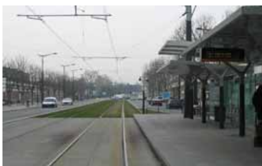
写真8 T3のプラットフォーム状況
