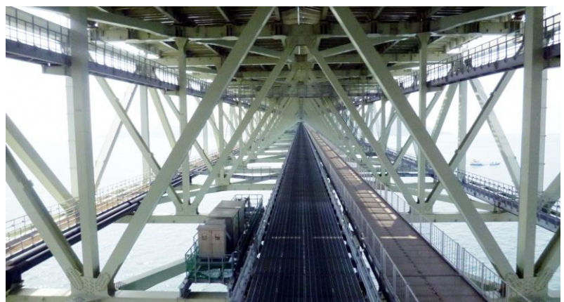
中央点検通路
