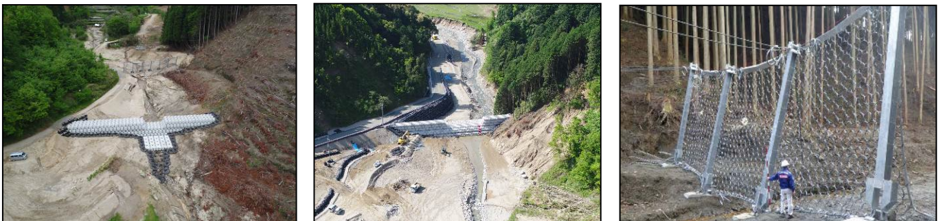
①仮設砂防堰堤工
