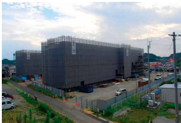
下神白団地（いわき市）工事状況 （平成26年8月現在）
