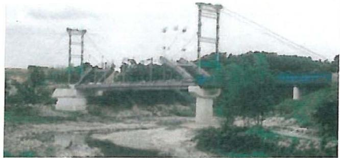
橋構造形式が3径間連続(下路式ローゼ桁+鋼箱桁)の新飯野橋
